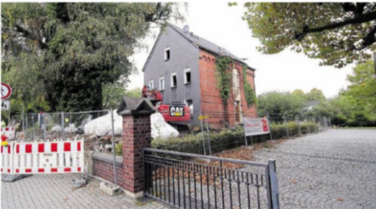
Vorher: das alte Pfarrhaus und die Mauer davor werden abgerissen.
