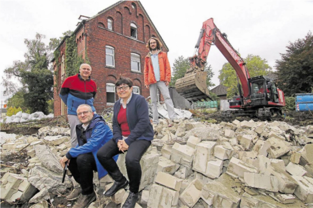
Die Garagen sind bereits gefallen, der Abriss des alten Pfarrhauses soll am Freitag beginnen. Hausmeister Jens Kowalke, Pfarrer Guido Hoernchen, Pfarrsekretärin Barbara Werner und Gemeindefereferent Bastian Lauf (v. li.) auf dem Gelände, auf dem ihr neuer Arbeitsplatz entsteht. FOTOS SCHUH
